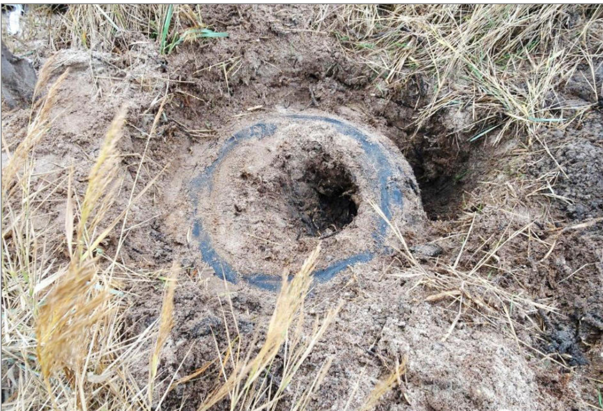
Abb. 4: Freigelegter Altreifen mit Aushubloch für die Kranschlinge. (Foto: NABU RV MM)
