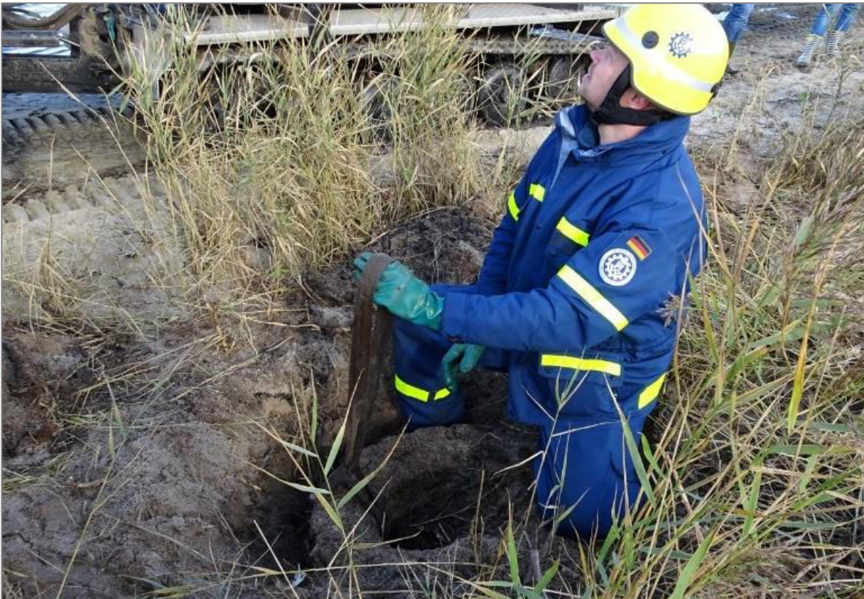
Abb. 7: An den freigelegten Reifen wird eine Seilzugschlinge befestigt, damit sie mit Hilfe des Krans aus dem Sand gezogen werden können. (Foto NABU RV MM)
